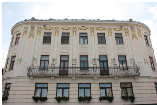
Slika 11. Zgrada u Splitu
