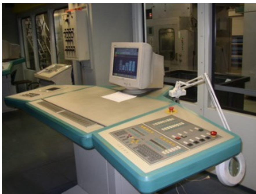
Fig. 25. Kontrolni upravljački pult novinske rotacije Geoman
