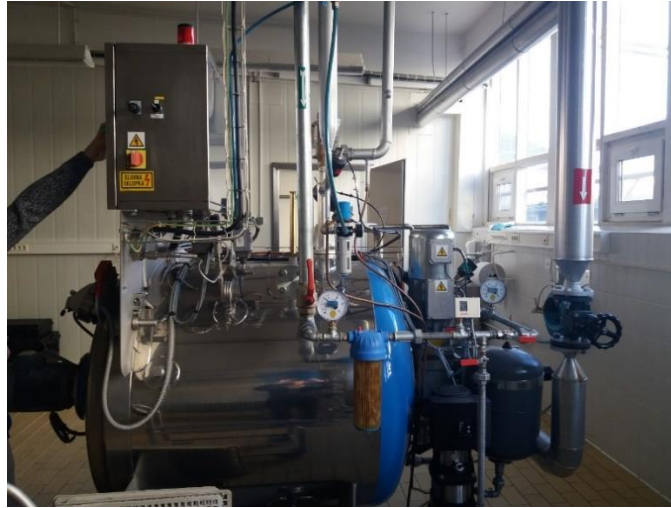
Slika 6.13. Autoklav za šaržnu sterilizaciju
